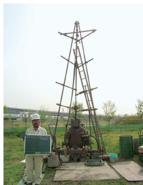
ボーリング調査(参考写真)
