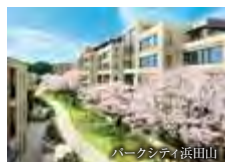
分譲マンション
