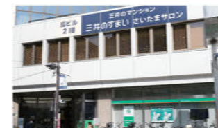
「北浦和」駅南口西側の銀行のビルです。
