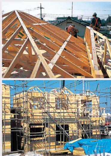
**06** 小屋組工事を行い、屋根垂木を組みます。この時、屋根の吹き上げを防ぐために、垂木は2×4工法独自の補強金物・ハリケーンタイで軒裏から壁にしっかりと緊結します。
