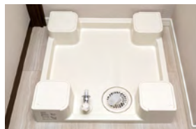
① 洗濯機防水パンの排水部のホース接続部を取り外します。
