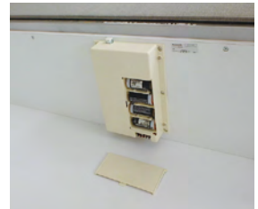
▲畳下収納内の電池ボックス
