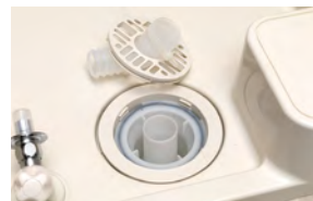
② 内側の十字の羽の部分を外側に回して取り外します。
