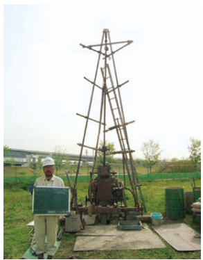
ボーリング調査(参考写真)
