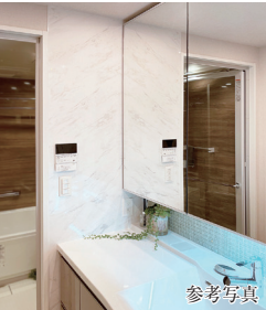
ホーローパネル設置
