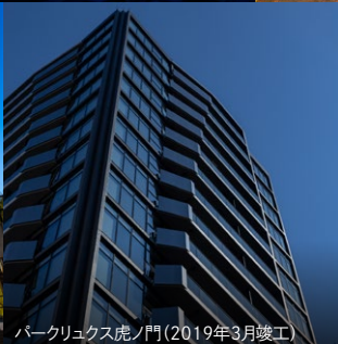
パークリクス虎ノ門 (2019年3月竣工)
