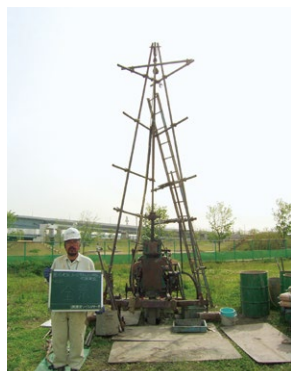
ボーリング調査(参考写真)
