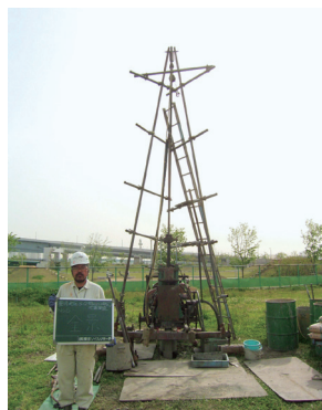
ボーリング調査(参考写真)
