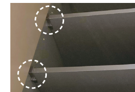
棚板脱落防止用ツメ (参考写真)
