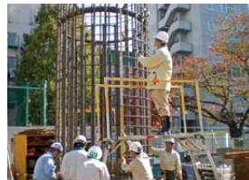
杭鉄筋確認(参考写真)
