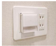
足元停電灯(参考写真)
