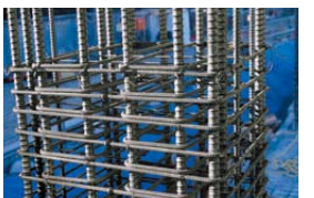
溶接閉鎖型せん断補強筋(参考写真)
