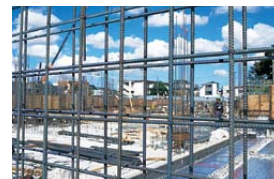
ダブル配筋(参考写真)
