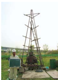
ボーリング調査(参考写真)
