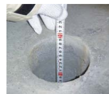
スラブ厚確認(参考写真)
