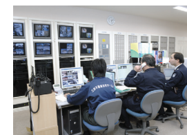
防災センター(参考写真)
