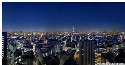
パークアクシスプレミア日本橋室町 【東京都中央区／2014年1月竣工／54戸】
