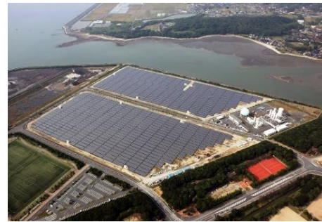
三井不動産山陽小野田発電所
