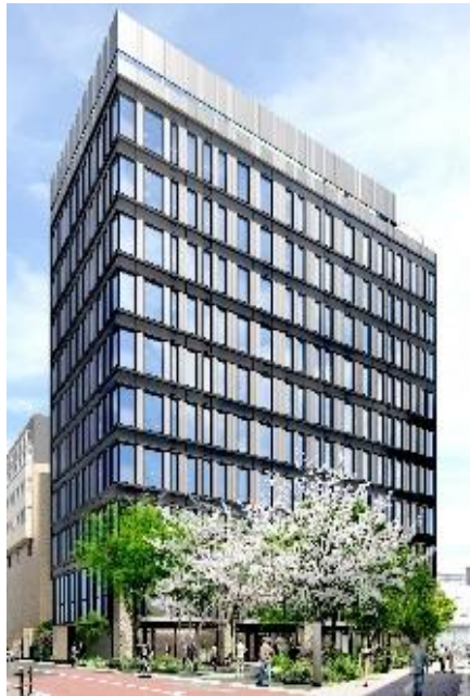
田町 M-SQUARE Garden (ZEB Ready)
