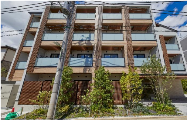
【バルコニースラブ・縦ルーバー】
