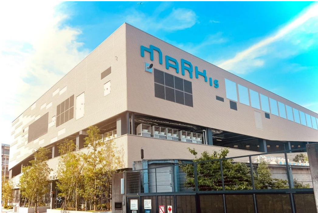
▲MARK IS 葛飾かなまち（南西より）
