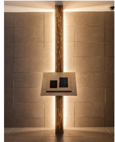
オートロック操作盤設置台
